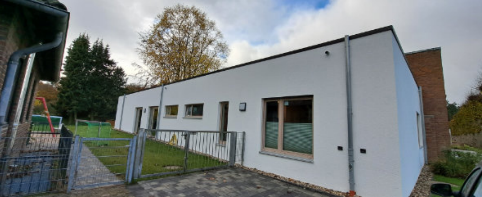
In strahlendem Weiß: Der neue Anbau am Kindergarten St. Markus in Schneppenbaum
